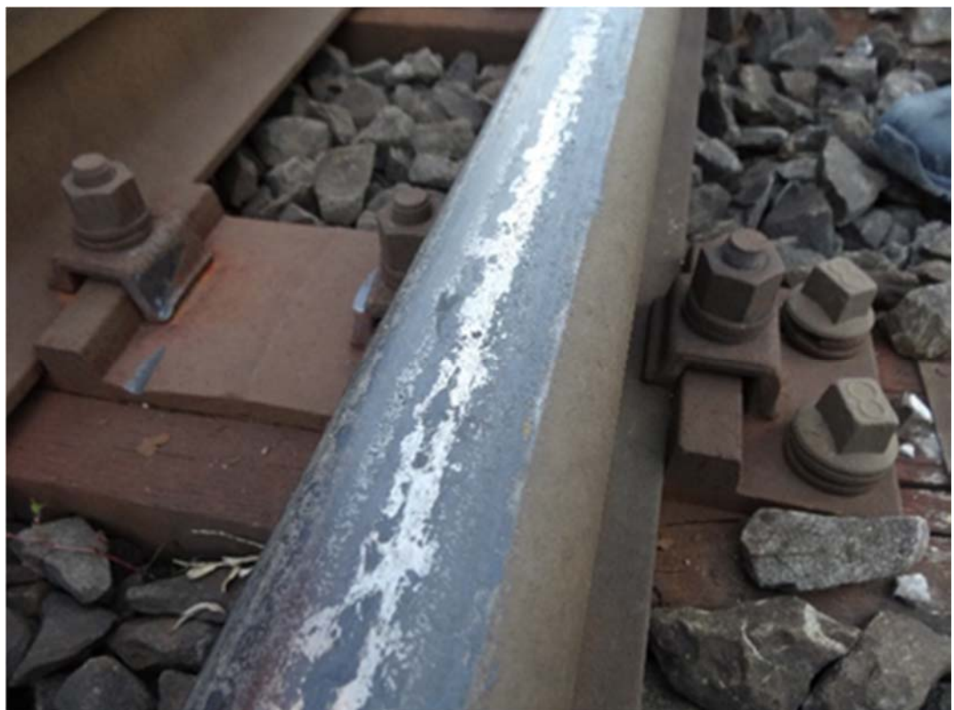
Abbildung 4: Verschmutzung des Schienenkopfes der rechten Schiene mit Fugenvergussmasse.
