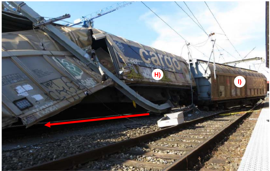
Abbildung 3: Sicht gegen die Fahrtrichtung auf die Güterwagen H und I sowie auf einen der beschädigten Fahrleitungsmasten. (Roter Pfeil: Fahrtrichtung)
